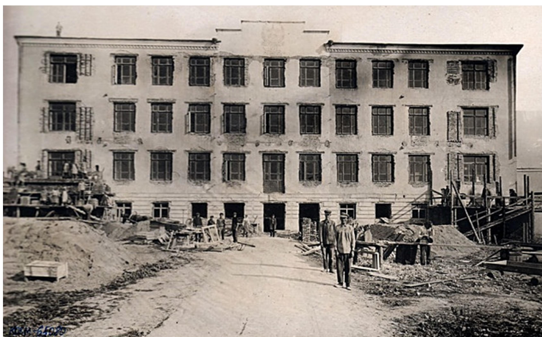
Рис. 8. Курск, лето 1935 года. В здании Курского государственного медицинского института расширили оконные проёмы и уже вставили рамы. В настоящее время это здание является
